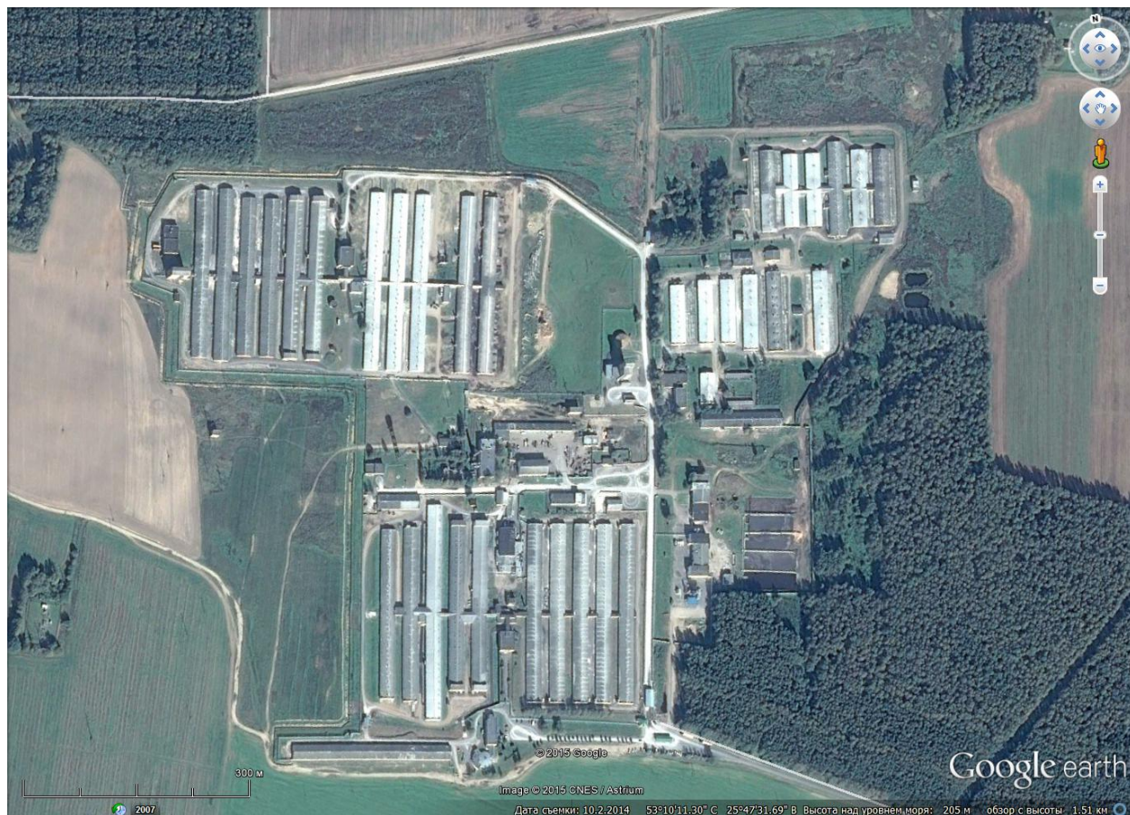
Рис. 3.1 Аэрофотосъемка площадки реконструируемых зданий с компонентами природной среды
